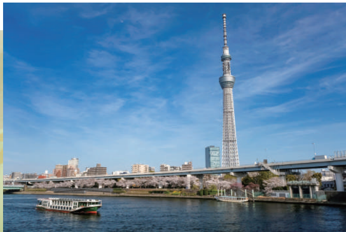
東京スカイツリー 世界一高い自立式電波塔（高さ634m）
